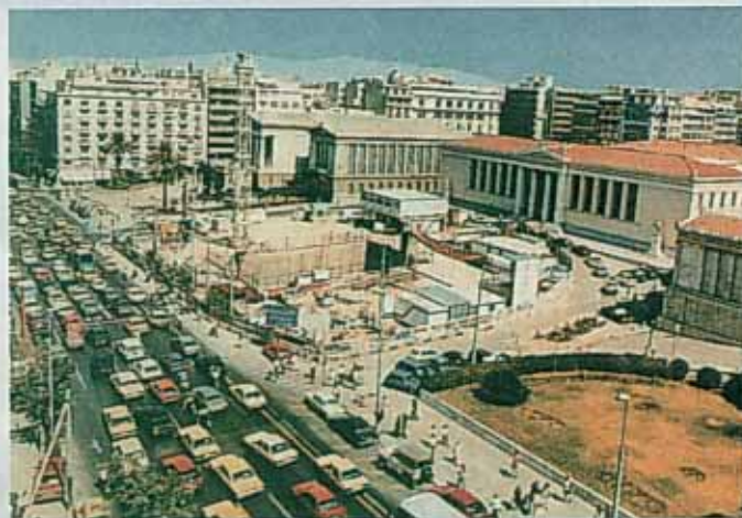
Οδός Πανεπιστημίου την εποχή της κατασκευής του Μετρό. (φωτ. 2-3: «Και περνούσανε τα τραμ...») Ευώνυμος Οικολογική Βιβλιοθήκη, 2003)
